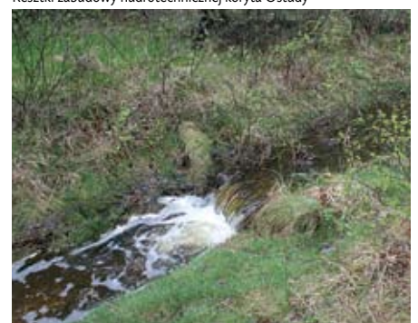
Resztki zabudowy hudeotechnicznej koryta Ostudy
