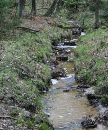
Resztki zabudowy hydrotechnicznej koryta Ostudy
