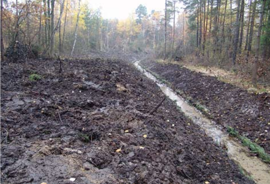
Koryto i dolina Ostudy po wykonaniu „zabudowy przeciwpowodziowej” (GCh)
