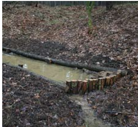
Zabudowa hydrotechniczna w bocznym dopływie Ostudy (JBP)
