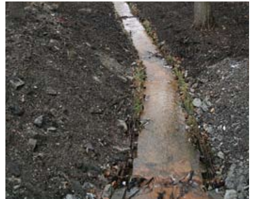
Wykopane rowy melioracyjne w źródłiskowym odcinku Ostudy (JBP)
